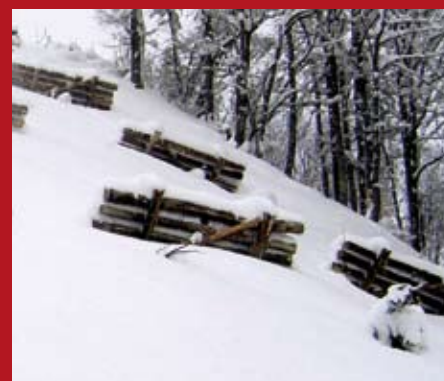
Lawinenschutz System AGS im Wintereinsatz im Steilhang
