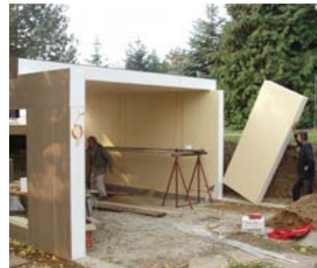
Wellness-Badehaus, ganz isotherm gebaut mit elektrischer Flächenheizung im Paneel!
